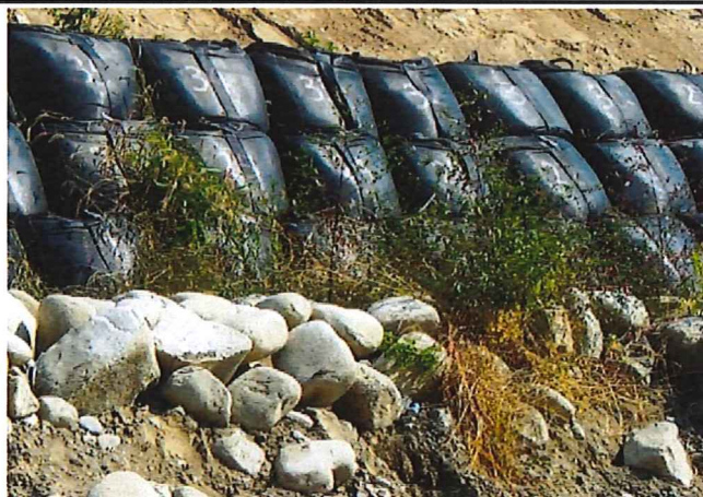
土留め使用例
