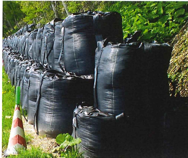
落石防護使用例
